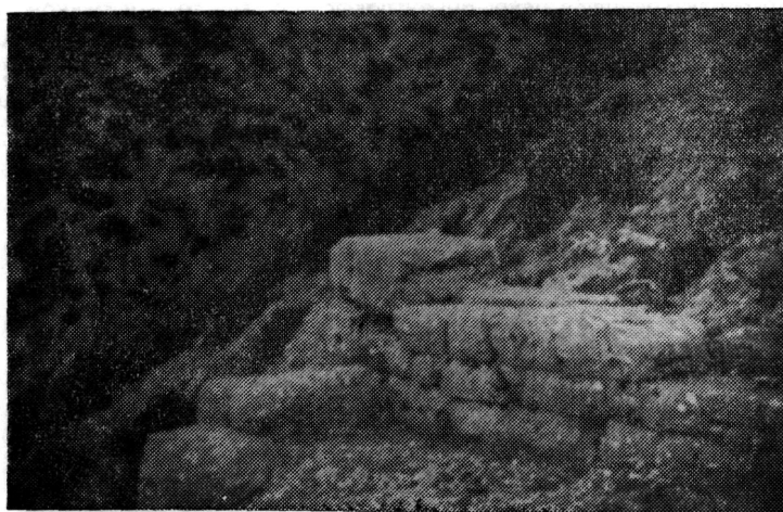
ΒΔ γωνία έσωτερικῶς
